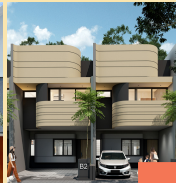
ASTERLOKA CLEA di Tangerang Selatan
